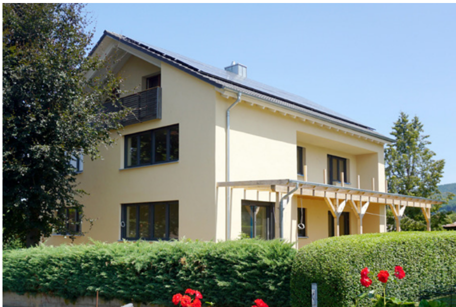
Abschließend erhält das diffusionsfähige WDVS eine pigmentierte Dispersionsilikatfarbe, welche die Makroporen verschließt.
