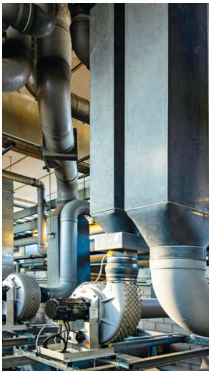
Neue Ventilatoren mit über 80 Prozent Motorenwirkungsgrad: 68 Radialluftventilatoren in den Baugrößen 160 bis 250 hat HLU im Gebäude N260 im Biozentrum verbaut.
