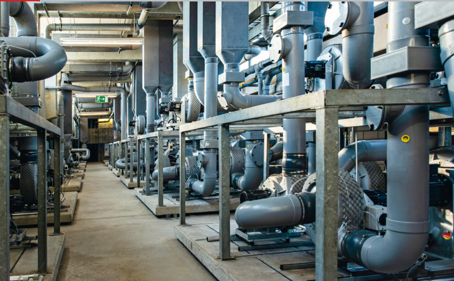
**Sanierung der Sonderablüfter: Technisch optimal ausgelegte hocheffiziente Radialventilatoren mit EC-Motoren und einzigartiger Laufrad-geometrie ermöglichen einen Teillastbetrieb im Biozentrum.** Foto: Hürner Luft- und Umwelttechnik (HLU)
