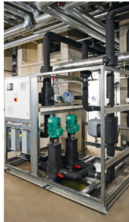
*EcoCond in Vollversion: Die Wärmerückgewinnung hat nach der Sanierung einen Wirkungsgrad von mindestens 69 Prozent.*
