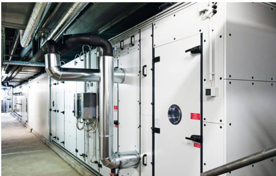
*55 Prozent weniger Strom- und 60 Prozent weniger Wärmeverbrauch: Die neue RLT-Anlage ist ein Grund für die Energieeinsparung des Biozentrums. Foto: Hürner Luft- und Umwelttechnik (HLU)*
